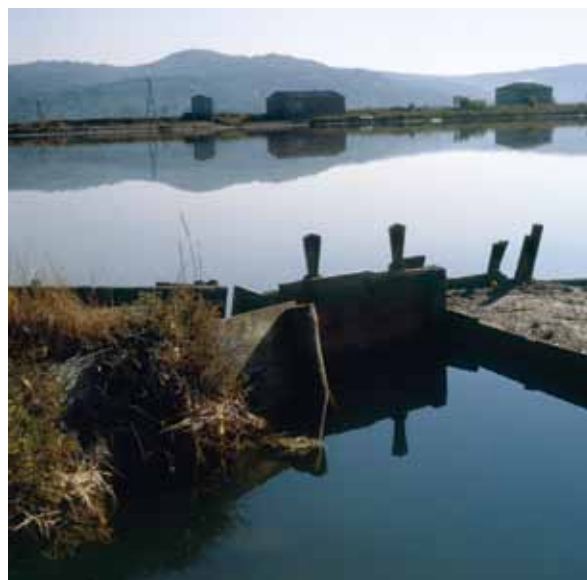
Lesene zapornice za regulacijo vode v solnih fondih
